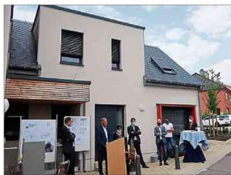
In der Rue de la Grotte hat die Gemeinde drei vergünstigte Wohnungen geschaffen. Foto: Volker Bingenheimer
